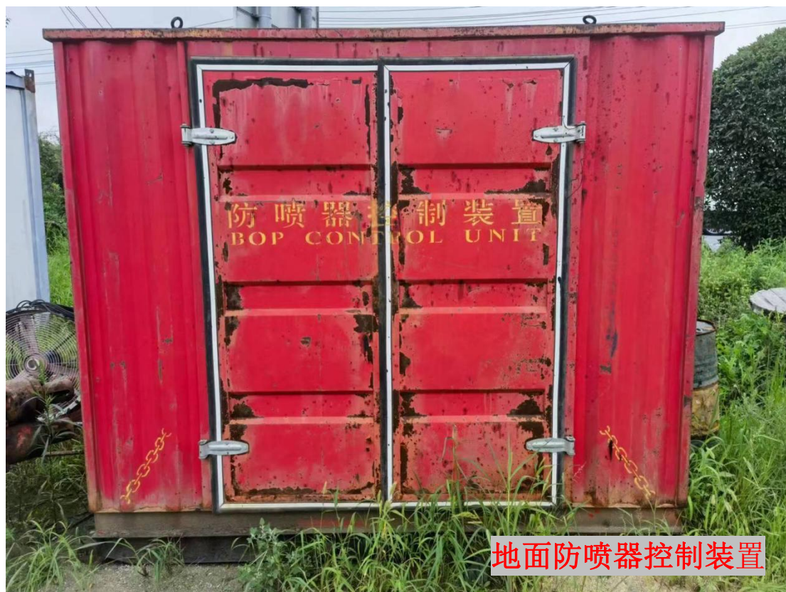
图 5.2 不压井作业设备设施
